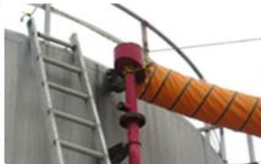
安裝試験用導管
