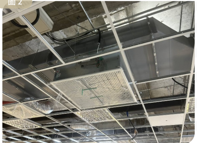
圖 2. 排煙閉門及風管與裝修天花板配置(由陽鼎實業股份有限公司專業提供)
