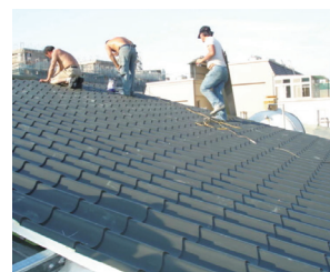
■鋪設好的琉璃鋼瓦
